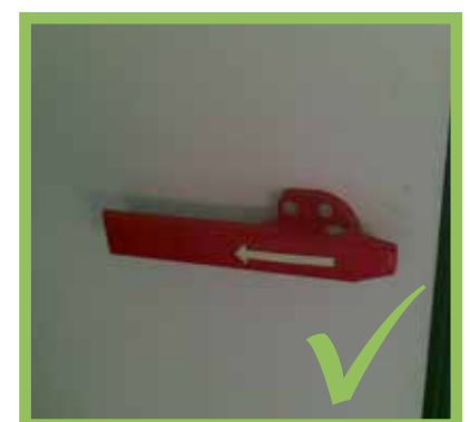
Saída fácil — coloque manipuladores de abertura fácil nas câmaras frigoríficas
