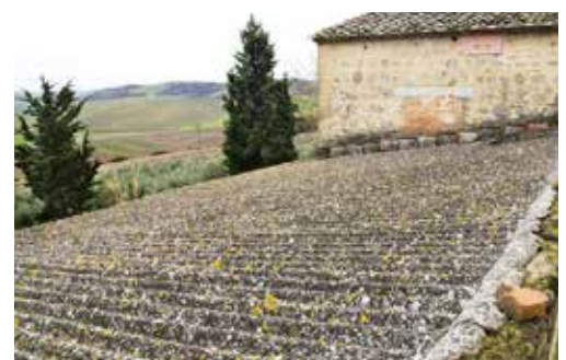
Substitua as coberturas no final dos trabalhos
